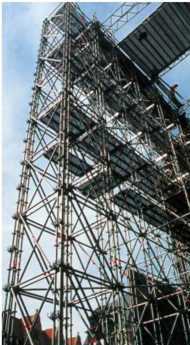
Durch Bündelung von vier Allround-Stielen wird eine extrem hohe Tragfähigkeit erreicht. Eine solche Stütze kann als Einzelstütze (15 t-Last), als Doppelstütze (30 t-Last) oder als Turm (60 t-Last) eingesetzt werden.
