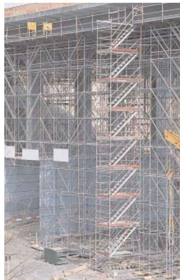
Das Layher AllroundGerüst als **Lehrgerüst**: Aufbau turmartig mit wählbarem Grundriß oder als Raumgerüst mit großen Stielabständen; durch variablen Stielabstand ist die Anpassung an die örtlich aufzunehmenden Lasten möglich.
