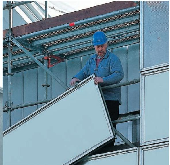
Das Protect-System bietet absolut zuverlässigen Schutz vor Umwelteinflüssen aller Art und erfüllt gleichzeitig höchste Anforderungen an die Stabilität. Sein modularer Aufbau mit Wand-, Dach-, Licht- und Schalldämm-Kassetten ermöglicht die Realisierung auch individuellster Aufgaben: Ob Asbest-Sanierung, Sandstrahlarbeiten, Lärm-, Wetter- oder Passanten-Schutz – beliebig große Flächen Fassade bzw. Wand können in kürzester Montagezeit wirtschaftlich bestückt werden.
