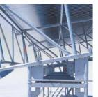
Das Dachauflager leitet die Dachlasten in die Tragkonstruktion und gleicht Differenzen in der Breite aus.
