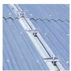
Dachkassetten werden mit Keilen verriegelt und liegen so abhubsicher auf; sie sind die begehbare Dacheindeckung und Binderaussteifung in einem.
