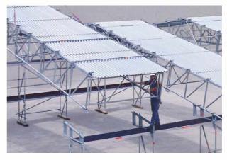
Die Träger werden am Boden verbunden, ausgesteift, die Dachkassetten aufgelegt und als fertige Einheit mit dem Kran auf das Traggerüst gehoben. Nur jedes zweite Dach-Feld wird als Binderfeld ausgebaut. Das spart Material und Aufbauzeit.
