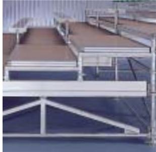
Die Event-Traversen-Unterstützung verhilft im 2,57-m-Feld zu 7,5 kN/m<sup>2</sup> Lastaufnahme; das Tribünen-Element gibt die Steigung vor und ist Auflager für die Event-Böden.
