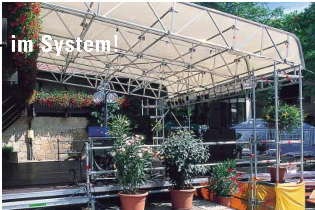
Serienmäßige Bauteile aus einsatzbewährten Gerüst-Systemen sind auch im Layher Event-System schnelle und zuverlässige Verbindungen.
